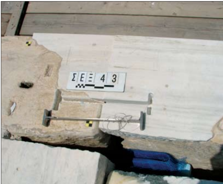
12 Τοποθέτηση συνδέσμου διπλού ταυ από τιτάνιο για τη σύνδεση δύο επιστυλίων της βόρειας πλευράς του Παρθενώνα.
