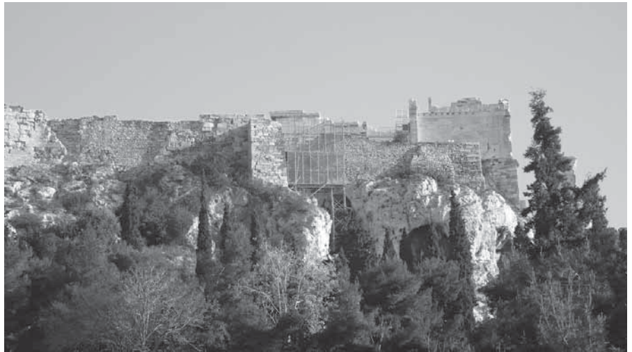
Βόρειο τείχος: διακρίνονται τα ικρίσματα στην περιοχή B17 της επικείμενης επέμβασης. Φωτ. Β. Εβλευθερίου, 2016
