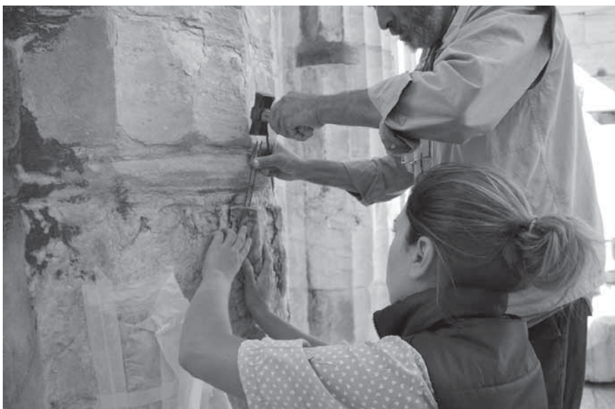
Εργασίες συντήρησης στην κιονοστοιχία της βόρειας πτέρυγας των Προπυλαίων. Φωτ. Π. Βλαχούλη, 2016
