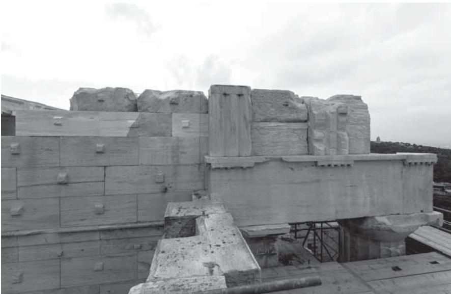
Αποψη από βορρά της ΒΔ γωνίας του κεντρικού κτηρίου των Προπυλαίων. Φωτ. Κ. Καρανάσος, 2016
