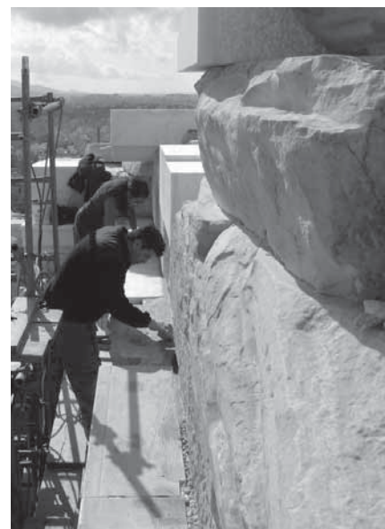
Εργασίες συντήρησης στο εσωτερικό του δυτικού αετώματος του Παρθενώνα. Φωτ. Σ. Γαβρηηίδου, 2016
