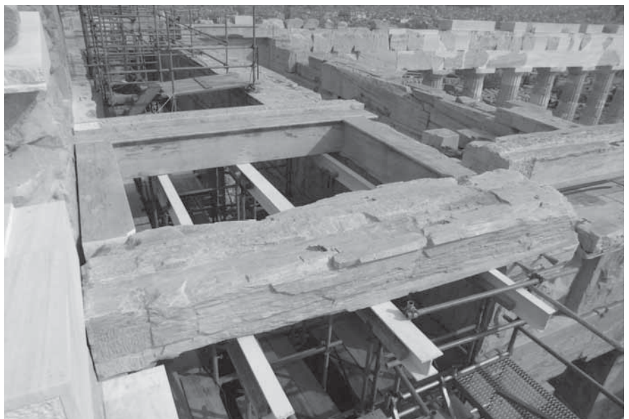
Αποψη των δύο ανατοποθετημένων δοκών της οροφής του δυτικού πτερού του Παρθενώνα. Φωτ. Ρ. Χριστοδουλοπούλου, 2016
