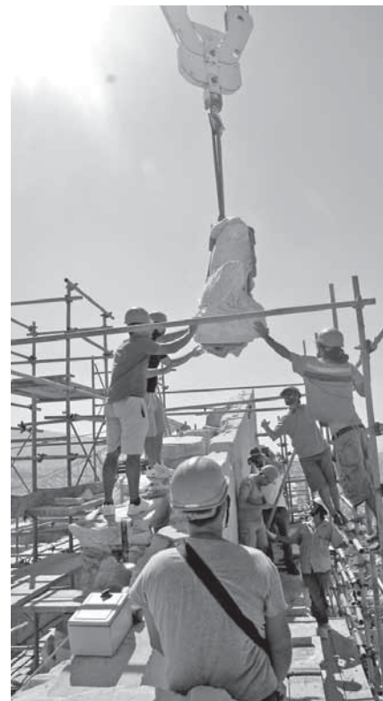
Το αντίγραφο του συμπλέγματος Κέκροπα-Πανδρόσου κατά την τοποθέτησή του στο μνημείο. Φωτ. Ε. Ταβουκτσή, 2015
