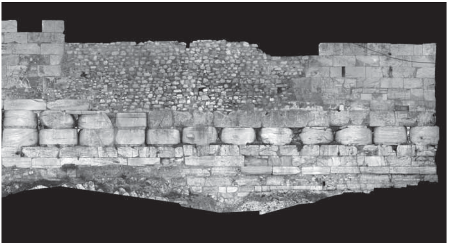
Βόρειο τείχος, περιοχή B12 της επικείμενης επέμβασης. Απόσπασμα ορθοφωτομωσαϊκού. Μελέτη ανάπτυξης ΓΠΣ στην Ακρόπολη των Αθηνών, 2009
