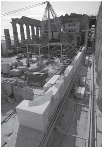
Εργασίες αποκατάστασης του πρώτου δόμου του βορείου τοίχου του σηκού του Παρθενώνα. Φωτ. Ρ. Χριστοδουλοπούλου, 2016
