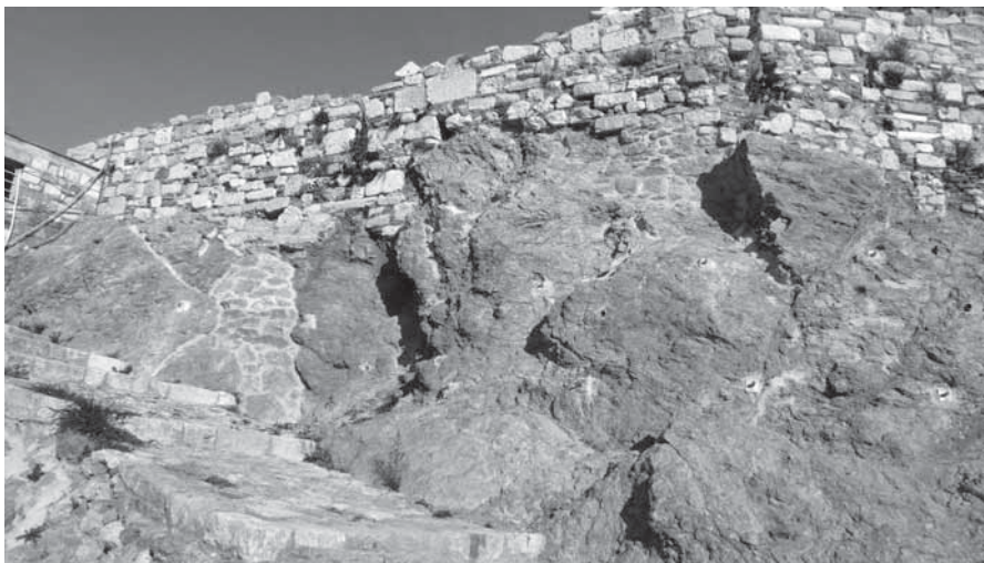
Άποψη του βραχώδους πρανούς στην ΝΔ κλητύ της Ακρόπολης, μετά τις εργασίες στερέωσης. Φωτ. Β. Ελευθερίου, 2016
