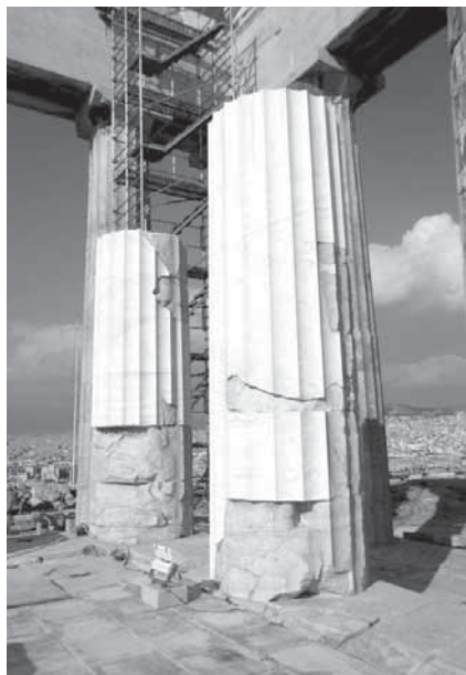
Οι δύο κίονες του Προναού του Παρθενώνα, μετά την ολοκλήρωση της βλάξευσης των ραβδώσεων. Φωτ. Ρ. Χριστοδουλοπούλου, 2016
