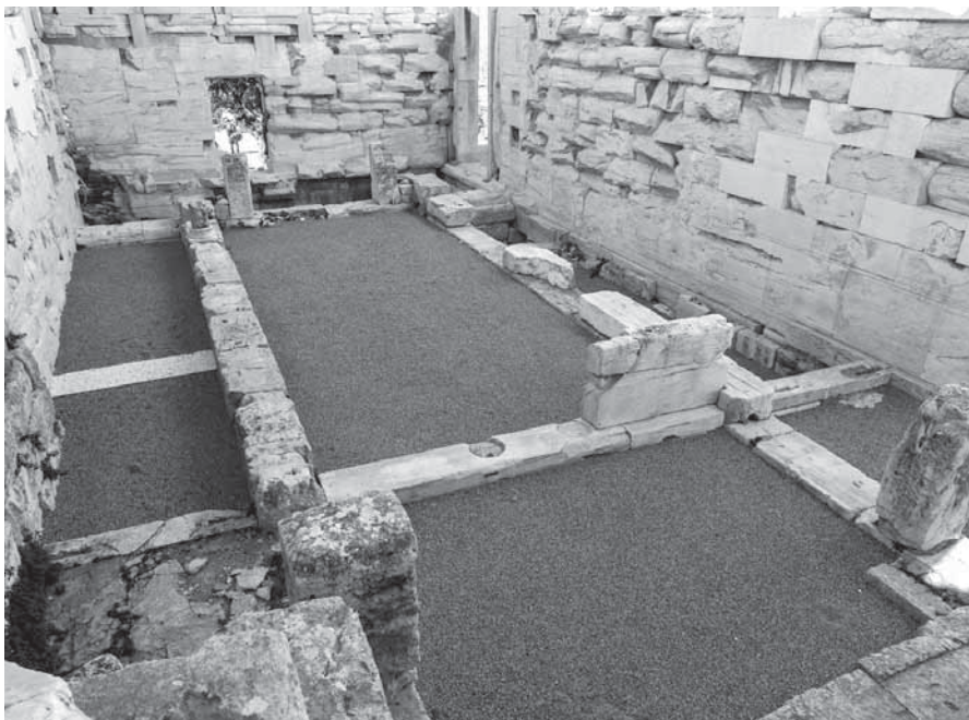
Το εσωτερικό του Ερεχθείου από Α. μετά την επέμβαση. Φωτ. Τ. Σουβλάκης, 2016
