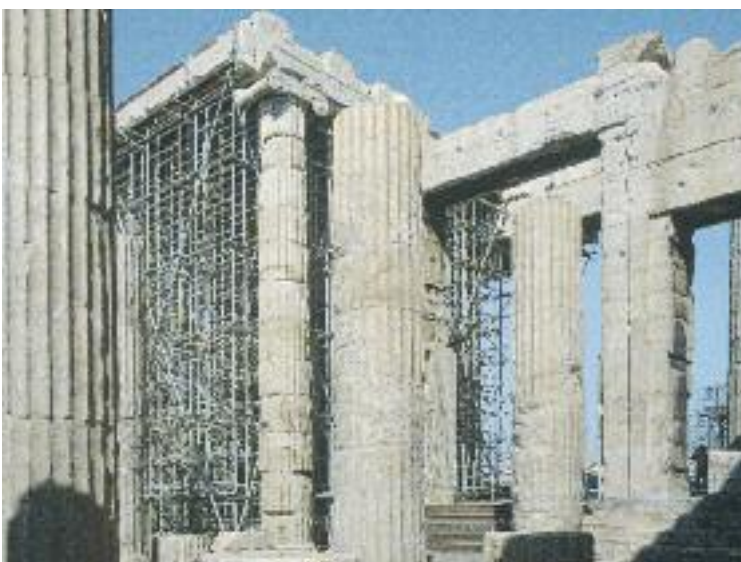
Άποψη του κεντρικού κτηρίου των Προπυλαίων
