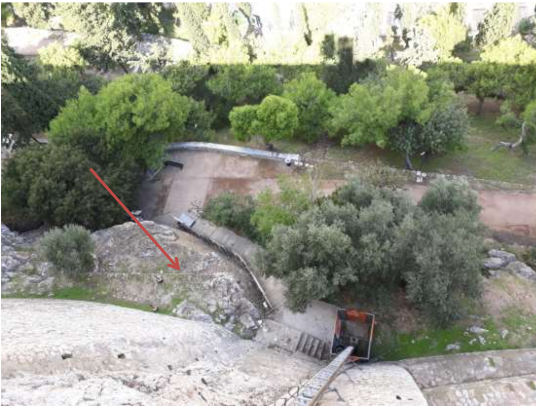
Εικ.4α. Ο χώρος πλησίον του ανελκυστήρα, όπου προβλέπεται να εδρασθεί το ικρίωμα και να διαμορφωθεί ο χώρος εργασίας
