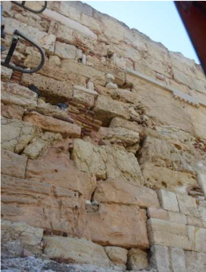
Εικ.2. Λεπτομέρεια της τοιχοποιίας στην περιοχή επέμβασης
