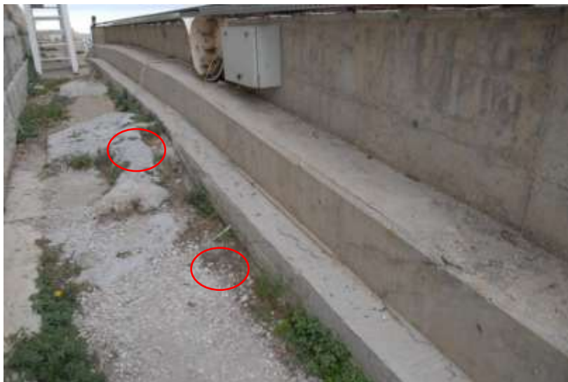
Εικόνα 4. Θέσεις σωλήνων PVC Φ50 προς χρήση για τις εργασίες συρματοκοπής
