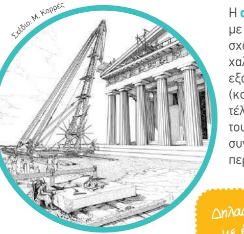
Η ανύψωση και η τοποθέτηση των λίθων γινόταν με διάφορα μέσα: γερανούς, τροχαλίες με σκοινιά, κυλίνδρους, μοχλούς ξύλινους και χαλύβδινους. Η σταθερότητα του κτηρίου δεν εξασφαλίζεται με υγρά συνδετικά υλικά (κονιάματα), όπως γίνεται σήμερα, αλλά με την τέλεια επαφή των λίθων, την κατάλληλη διάταξή τους και με τη σύνδεσή τους με ειδικούς συνδέσμους. Ανάμεσα από τους λίθους δεν περνούσε ούτε αέρας.
